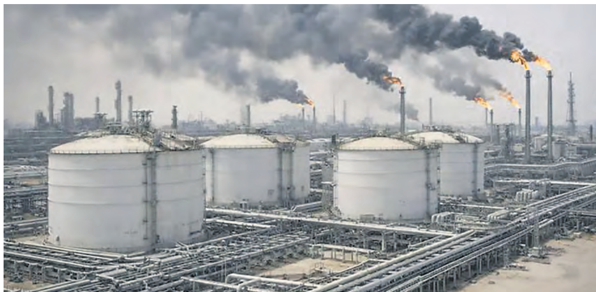
Usine de GNL au Qatar.
