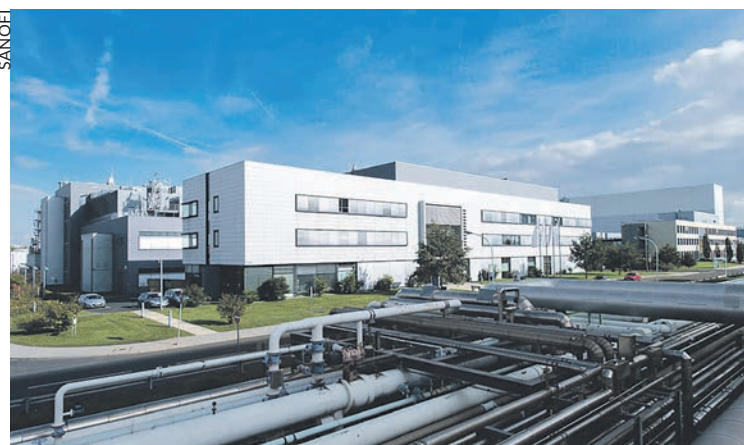
L'actuel site de production d'insuline à Francfort, qui sera bientôt remplacé.
