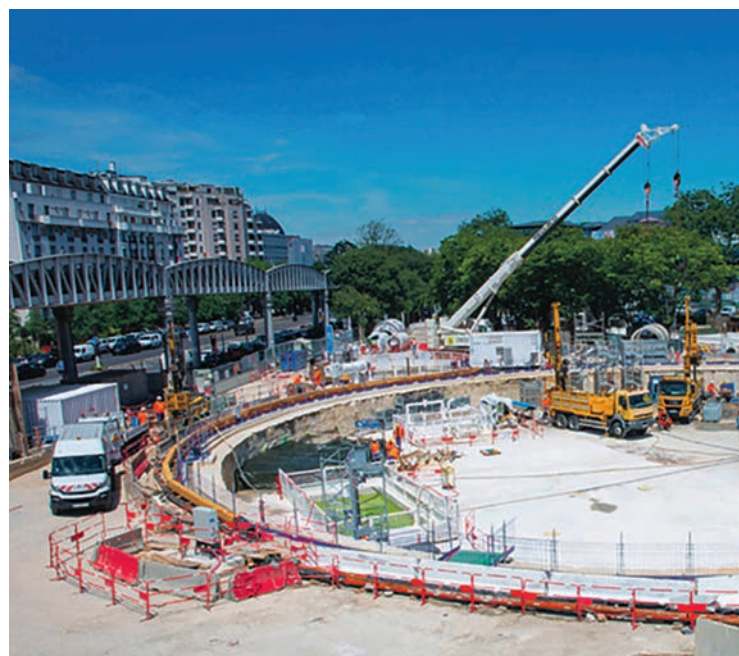
Le chantier des JO, sur lequel un maçon est mort en juin 2023.
