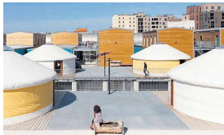
Centre d'hébergement d'urgence à Ivry-sur-Seine, construit en 4 mois.
