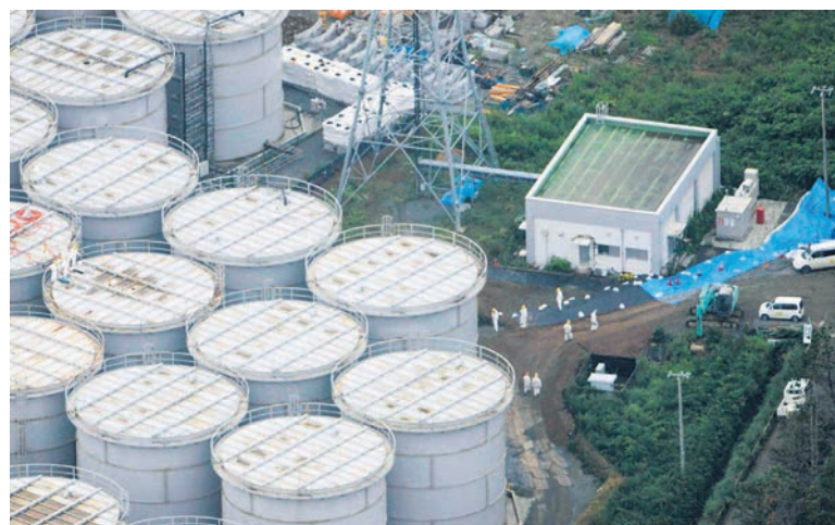
Les silos stockant l'eau contaminée.
