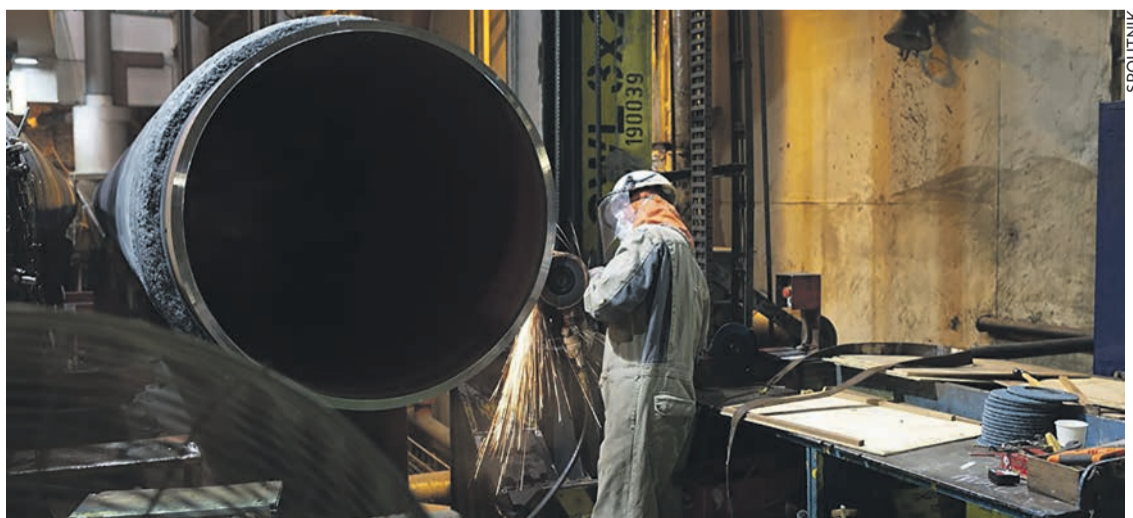
Construction des conduites de Nord Stream 2 en Russie.
