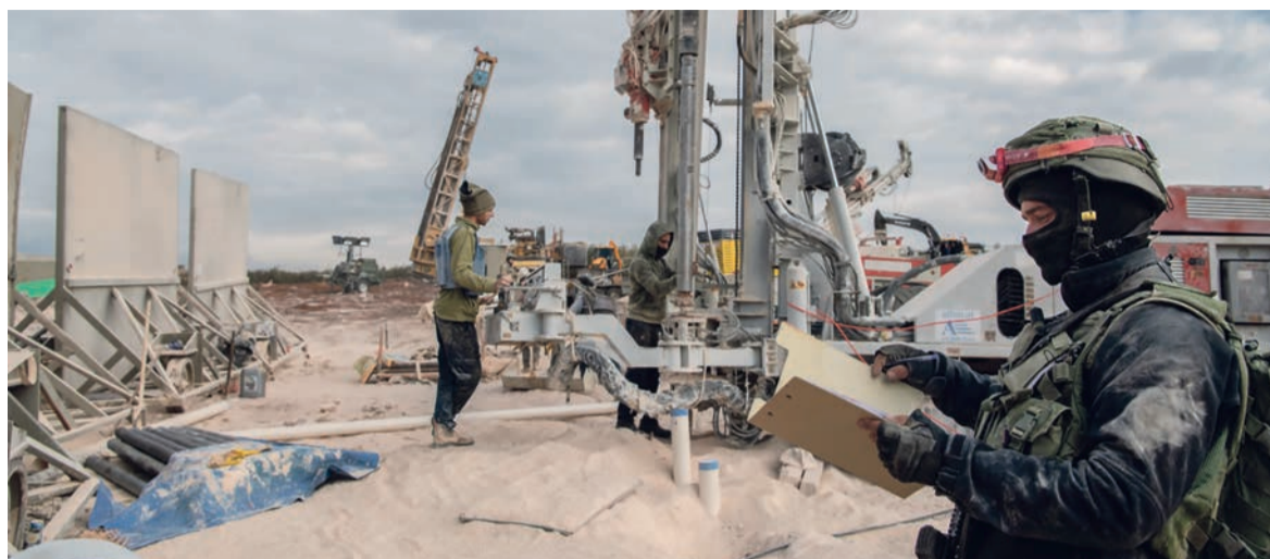
L'armée israélienne fouille le sol au sud de la frontière libanaise pour tenter de localiser et de détruire un tunnel du Hezbollah.
