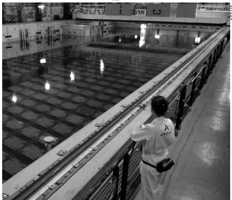
Une piscine de stockage de matériaux radioactifs.
