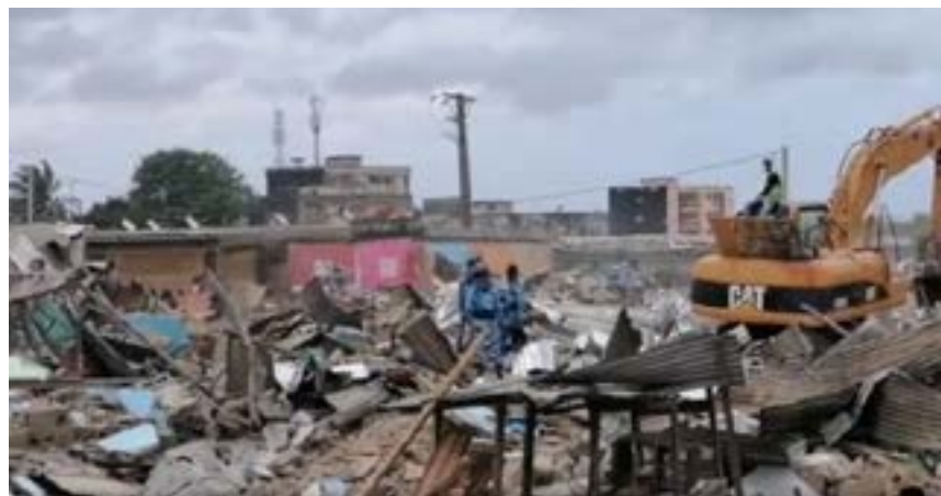
Destruction du quartier du carrefour Ferraille, à Yopougon, à Abidjan, le 7 octobre 2021, avec bulldozers et gendarmes. Beaucoup d'habitants n'ont nulle part où aller.
